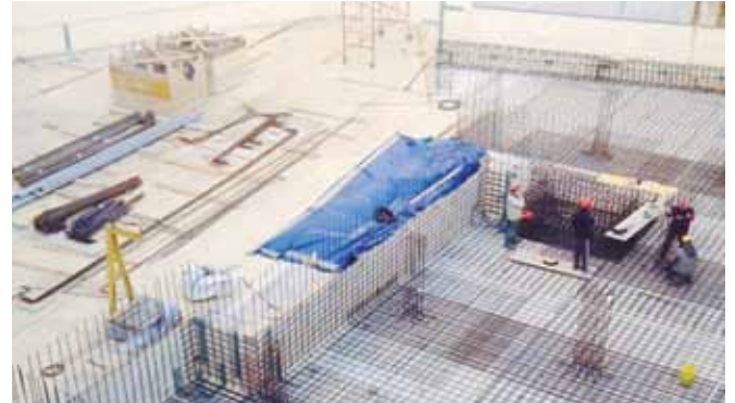
Procés d'impermeabilització durant la construcció.
